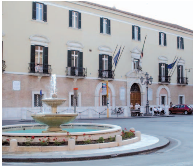
Foggia: Palazzo Dogana, sede della Provincia
